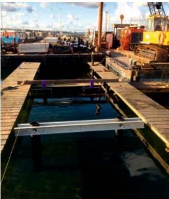
relativ schnell war der obere Holzbereich abgebaut
