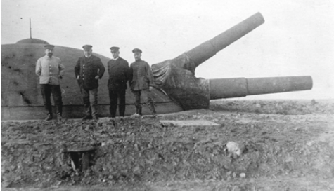
1902: Die Panzerkuppel des Turms mit den zwei 28-cm SK/L 40 Kanonen
