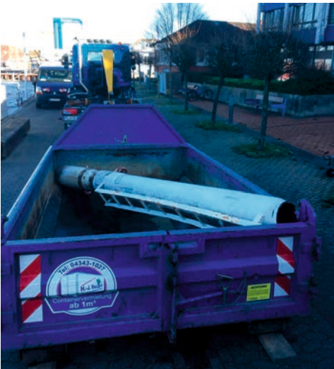
und das unterste Stück passte genau in den Container
